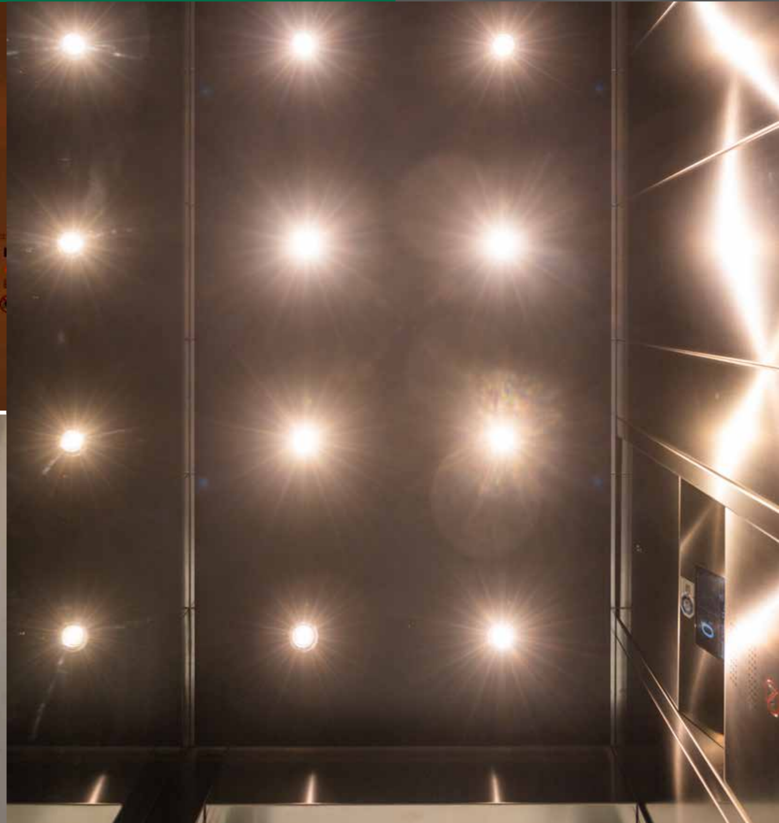
Abgehängte Decke mit LED Flächenleuchte
