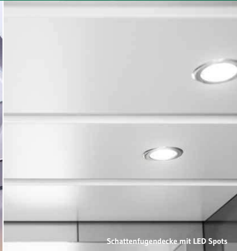
Schattenfugendecke mit LED Spots
