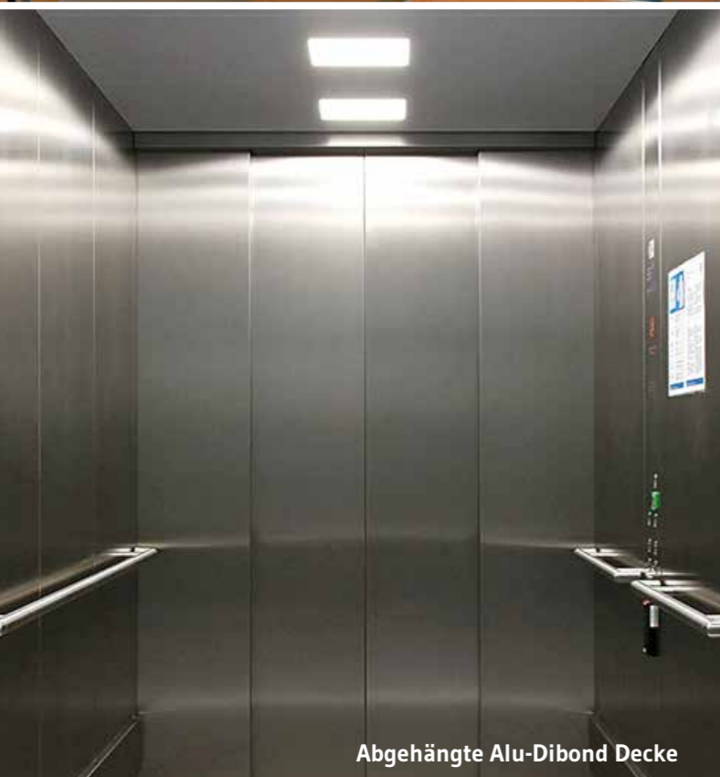
Abgehängte Decke mit indirekter Beleuchtung
