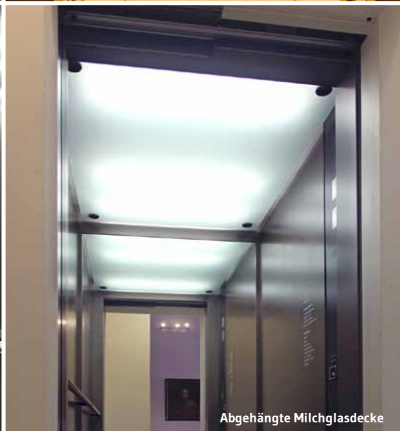
Abgehängte Decke mit LED Flächenleuchte
