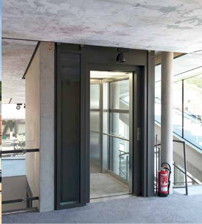
Objekt: Weingut Hiss Standort: Eichstetten
