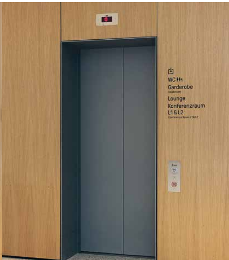
Objekt: Inselhalle Standort: Lindau
