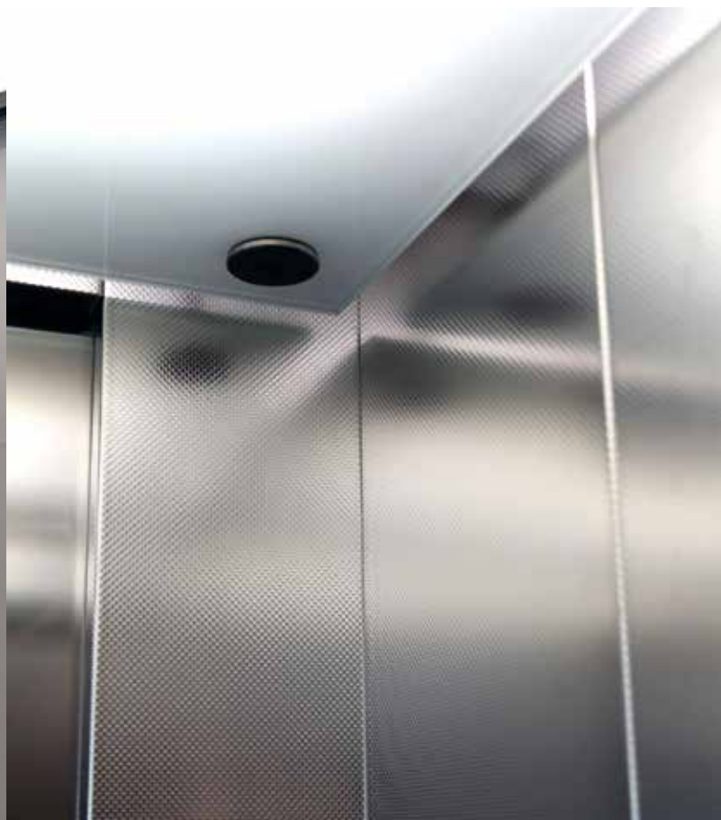
Detail: abgehängte Decke
