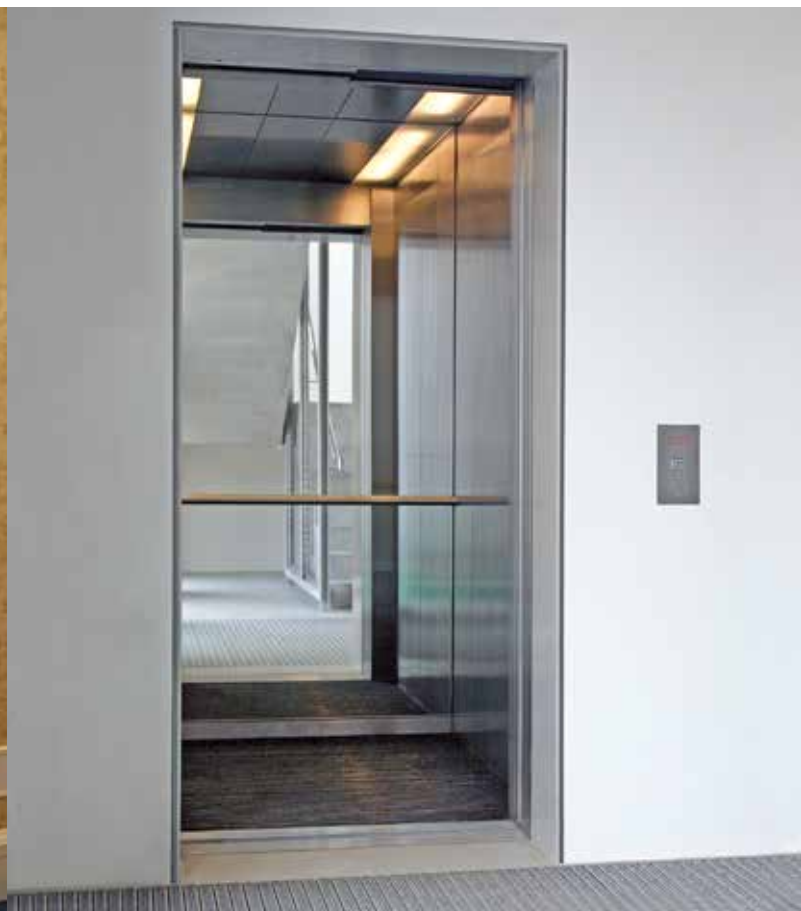
Objekt: Jugendhaus Bad Cannstatt Standort: Bad Cannstatt
