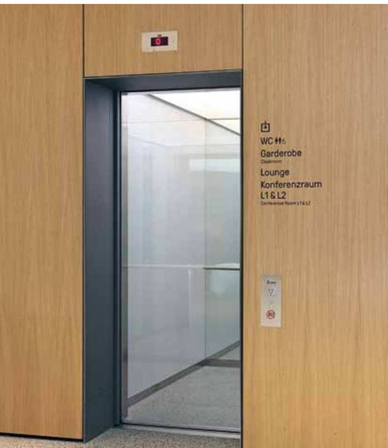
Objekt: Inselhalle Standort: Lindau
