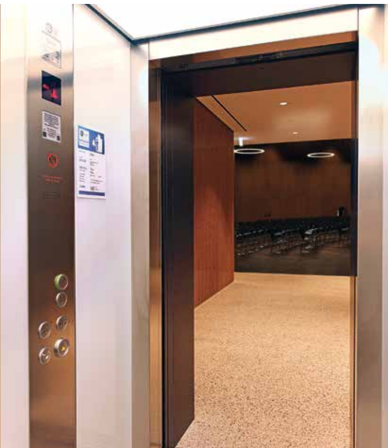
Objekt: Inselhalle Standort: Lindau
